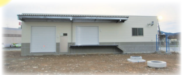
倉庫棟 (鉄骨造 平屋)
