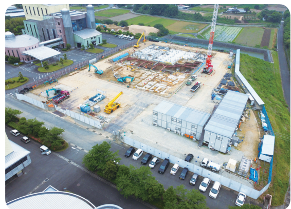
北西側より撮影（R4.5.23 現在）
