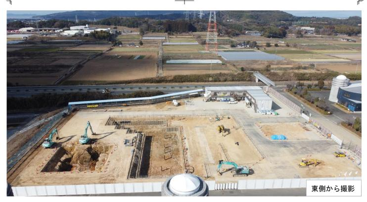
土留工事のSMW工が終了しました。2月に入り建築範囲の掘削が行われています。今後はいわゆる基礎工事が 行われます。
