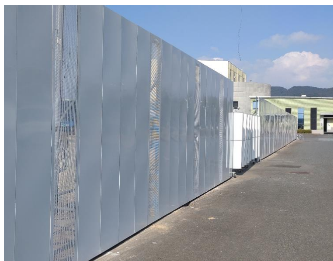
【仮囲いの設置】
