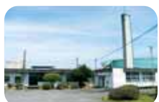
浄化センター
