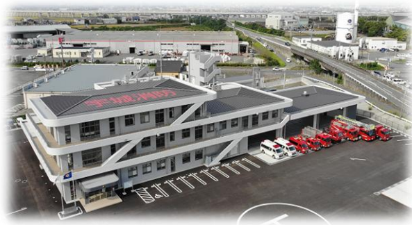
消防本部・北消防署庁舎
