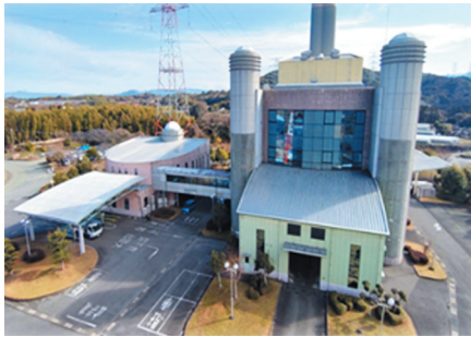
《旧ごみ焼却施設》
