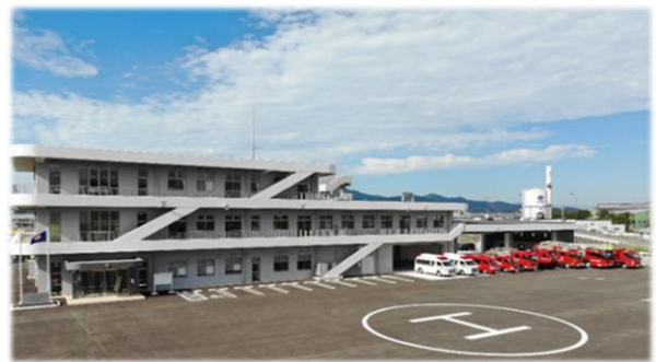
消防本部・北消防署
