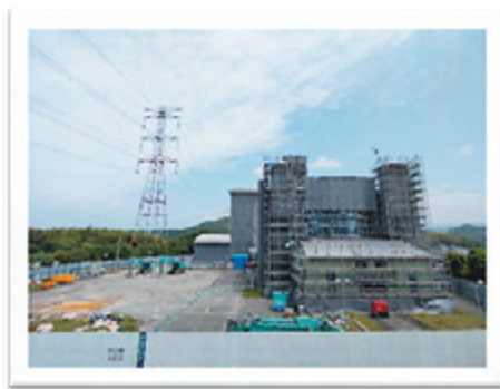
解体工事状況
