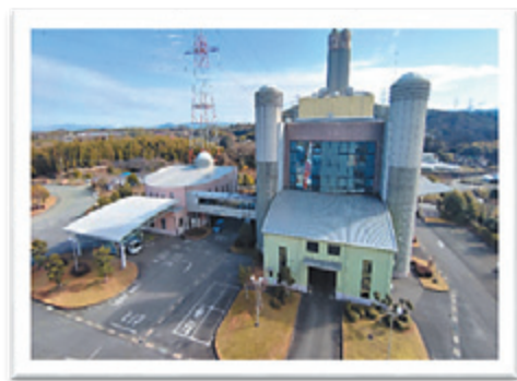
解体対象施設（旧ごみ焼却施設）
