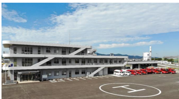
消防本部・北消防署新庁舎
