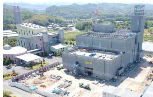
エネルギー回収型廃棄物処理施設整備工事
