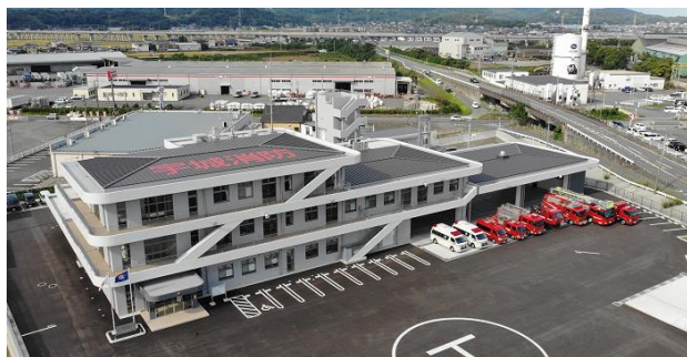
消防本部・北消防署新庁舎
