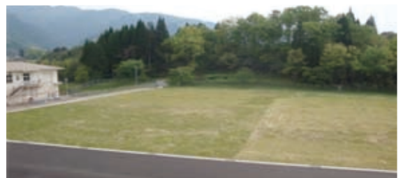
栗崎最終処分場覆土工事 平成27年3月25日
